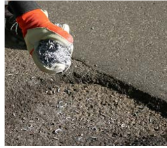
Tragen Sie zunächst eine maximal 15 mm starke Schicht auf.
