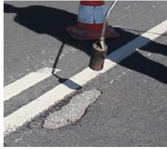
Erhitzen Sie den Reparaturbereich mit einem Gasbrenner, um diesen zu trocknen.
