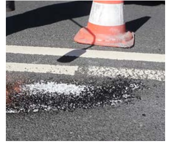
Erhitzen Sie das Material bis es leicht kocht und wiederholen Sie den Vorgang bei Bedarf.
