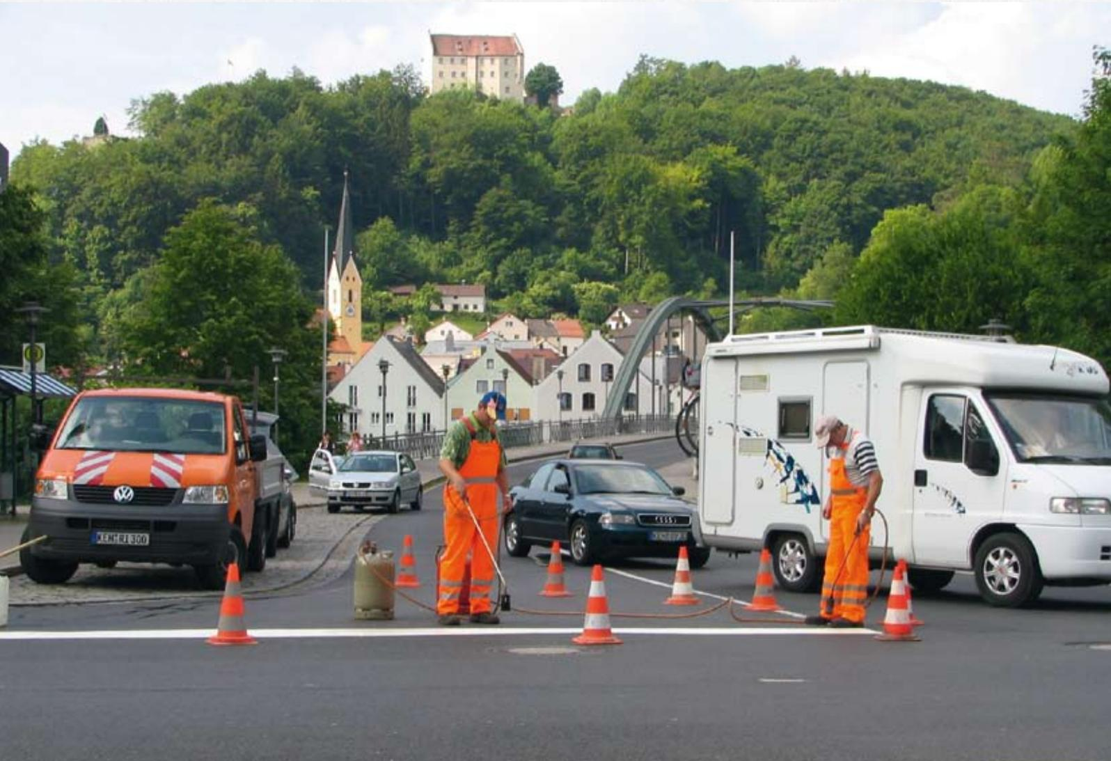
PREMARK® wird auch mit Reflexperlen auf der Oberfläche geliefert, um eine gute Anfangsreflektion der Markierungen des Nachts und bei Nässe zu gewährleisten.
